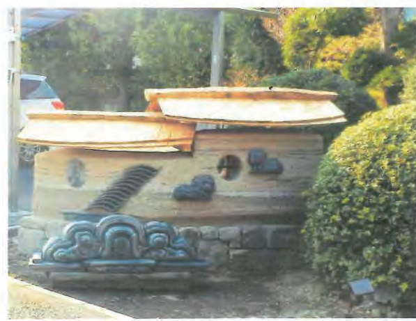
版築工法で製作した A邸 の土塀
